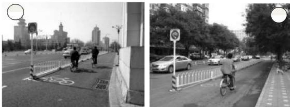
图 6-13 设置机非隔离护栏的主干路
