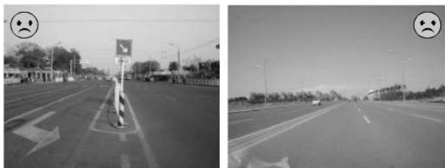
图 4-7 空旷，空间尺度失衡的道路
