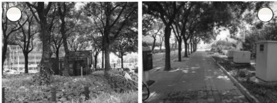
图 10-3 隐藏在绿地里的变配电设施
