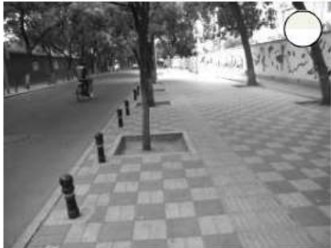
图 5-10 沿路缘石内侧设置的阻车桩
