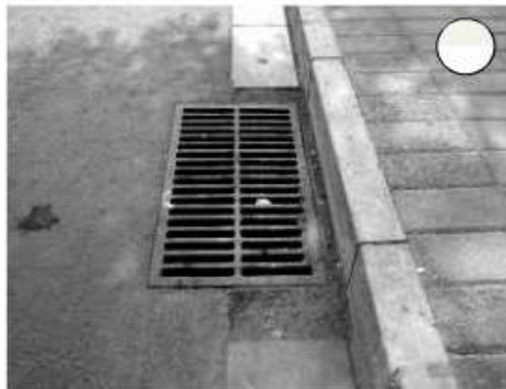
图 10-10 安全的雨水井算子
