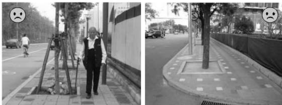
图 4-17 行道树树池位置不当，应紧贴路缘石设置
