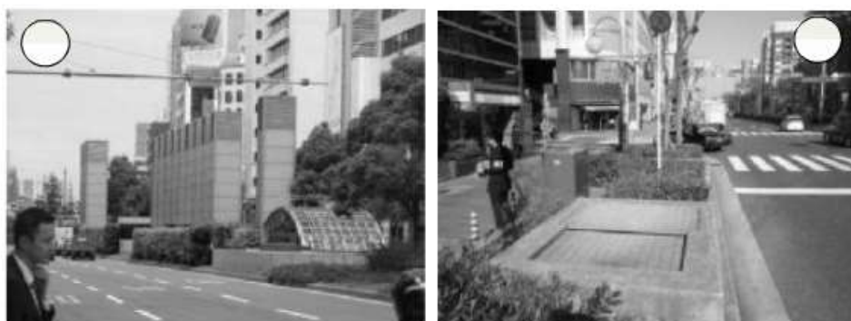
图 10-5 日本地下隧道、地下街出风口
