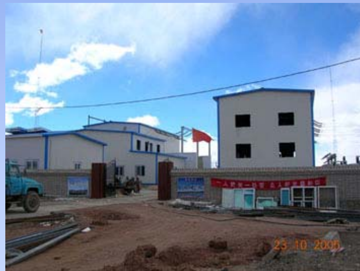
沱沱河变电站 2005年12月31日顺利投运
