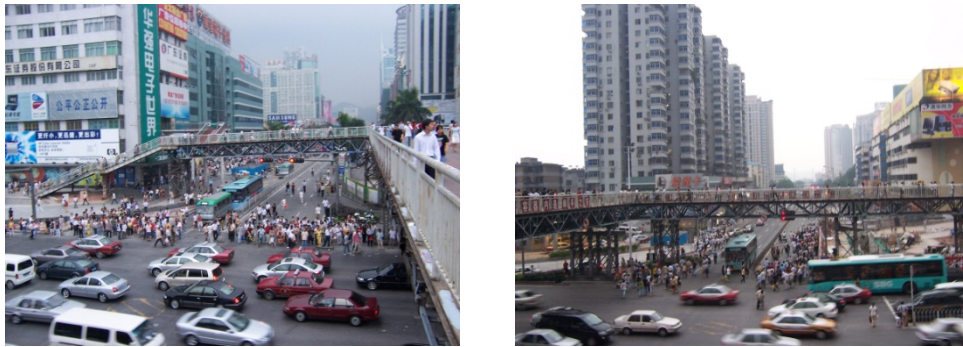
图 3 深南路/华强路过街天桥
