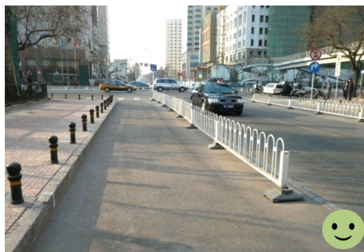
图 8.2.5 交叉口局部机非物理隔离正例
