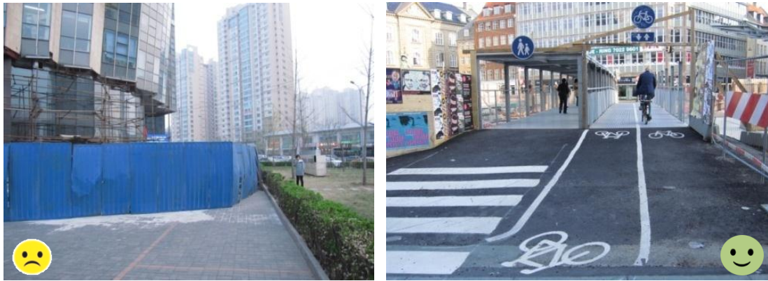
图 13.3.6 施工时保证行人和自行车安全通行反例与正例
