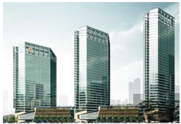
图17-10 华贸中心写字楼立面
