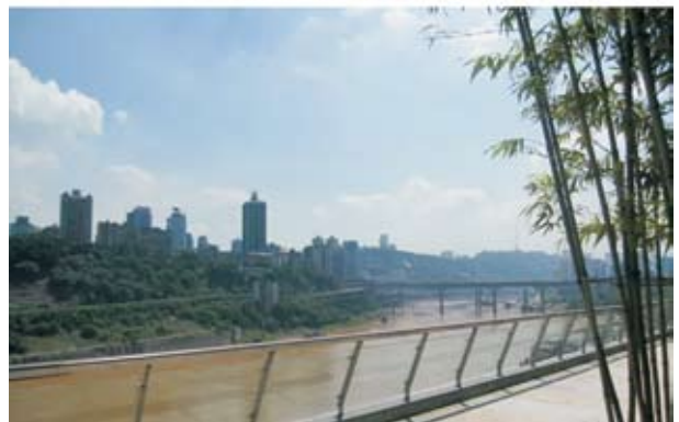
图19-4 重庆春森彼岸滨江建筑景观
