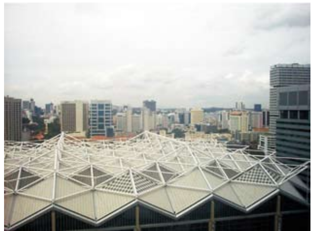
图15-8 新加坡国际会议与展览中心多角金字塔屋顶
