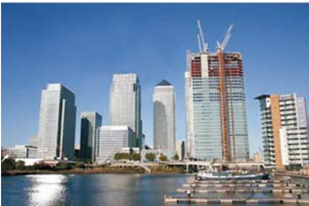
图6-22 在建的码头金融区
