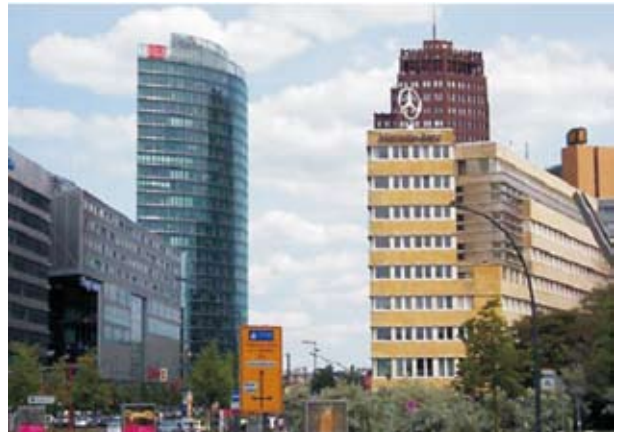
图9-6 左面玻璃幕墙建筑是索尼中心，右面是奔驰大厦与波茨坦广场大厦
