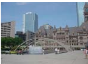
图2-6 弥敦菲腊广场老市政厅
