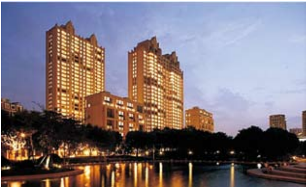
图18-6 上海太平桥建筑
