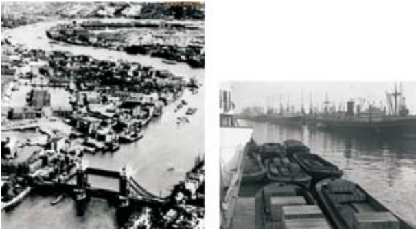
图6-6 改造前的码头区
