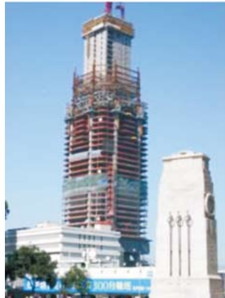
图16-11 正在施工中的国际金融中心二期
