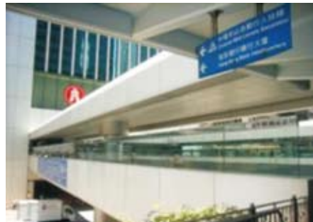
图16-10 中区行人天桥通往恒生银行大厦
