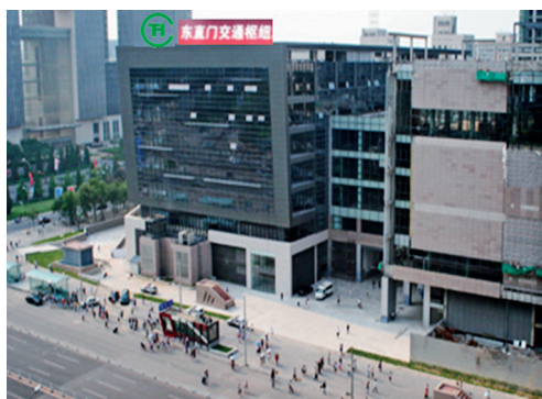
a 改善后的东直门枢纽主体建筑
