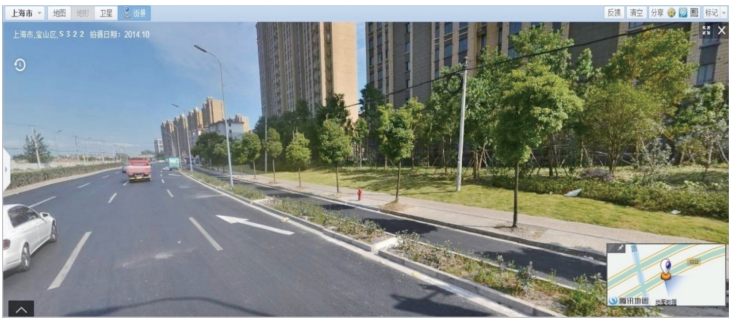
图3 改善后的宝安公路 Fig.3 Bao' an Road after improvement 资料来源：腾讯街景地图。
