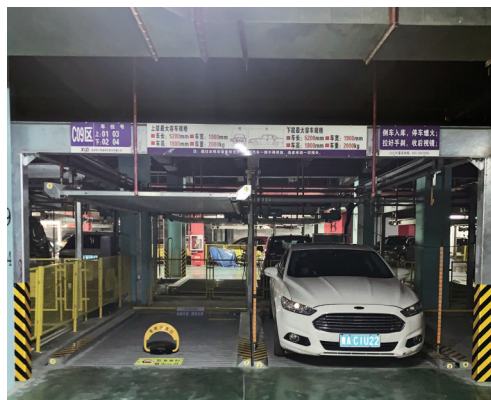
图11 贵阳市云岩区梦想典城小区利用地下车库建设的二层升降横移类停车库
