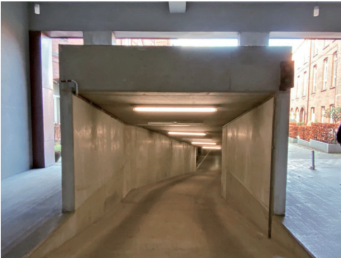
b 车库出入口坡道
