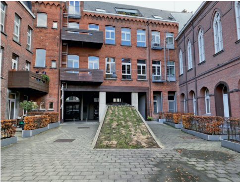
c 车库坡道外部
