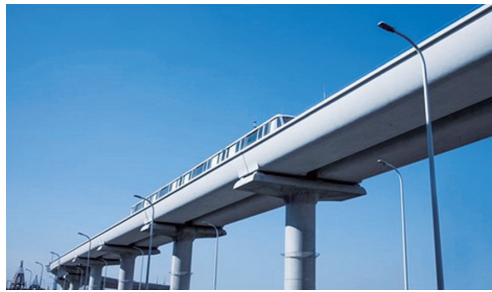
a 线路全高架敷设
