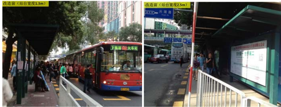
图5 东门①（东侧）站点施工改造前后示意图
