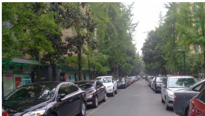
图 6 道路双侧停车后中间宽度不足 3 m
