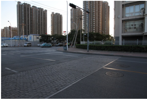
图 5 设置纹理路面减速带
