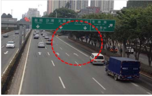
图 14 出入口处施划实线
