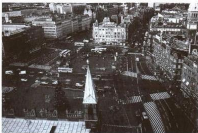
1996年,哥本哈根被授予“欧洲文化首都”的称号,促成了市政广场的改造。曾经割裂广场的交通干道被清除,公共汽车都集中在广场的一端。在市政厅前形成了一个宽阔而略有坡度的人行广场
